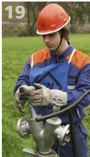
18 Dabei ist das Standrohr zu setzen, der Unterflurhydrant durch mindestens zwei volle Schlüsselumdrehungen zu öffnen und zu spülen. Die Drehrichtung des Unterflurhydrantenschlüssels ist nicht zu berücksichtigen.
