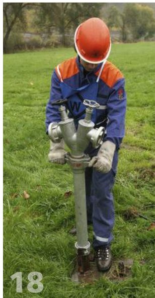
18 Dabei ist das Standrohr zu setzen, der Unterflurhydrant durch mindestens zwei volle Schlüsselumdrehungen zu öffnen und zu spülen. Die Drehrichtung des Unterflurhydrantenschlüssels ist nicht zu berücksichtigen.
