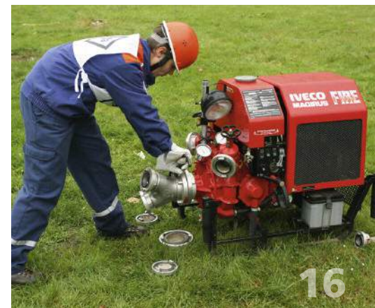
Der Maschinist kuppelt das Sammelstück mit Hilfe des Kupplungsschlüssels an die TS an.
